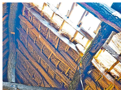
Der Blick von unten gegen das Reetdach. Es hat ausgezeichnete wärmedämmende Eigenschaften.
