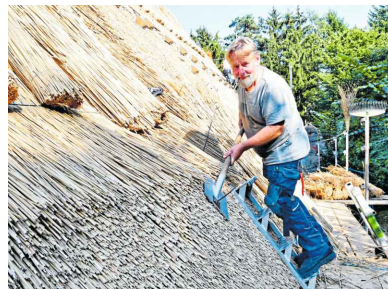
Reetdachdecker Wolfgang Thiel beim Decken des Germanischen Langhauses. Mit einem Klopfer gleicht er die Reethalme der Dachneigung an.
